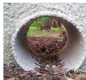
Exemples de mur-bahut avec passage à faune, Club « Urbanisme, Bâti et Biodiversité », LPO
