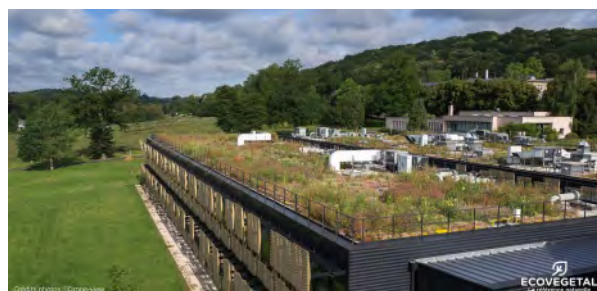
Toiture plate végétalisée de l'INRA - écovégétal
