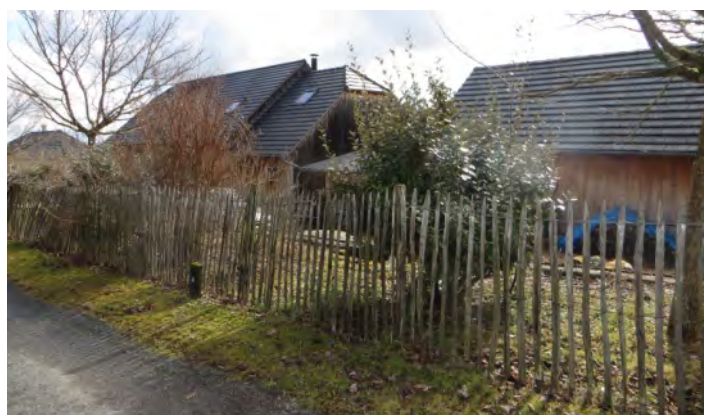
Clôture en ganivelles, PLUi Beynat, Beaulieu, Meyssac
