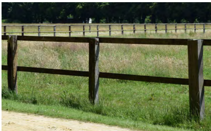
Clôture en bois en zone agricole, Cerema
